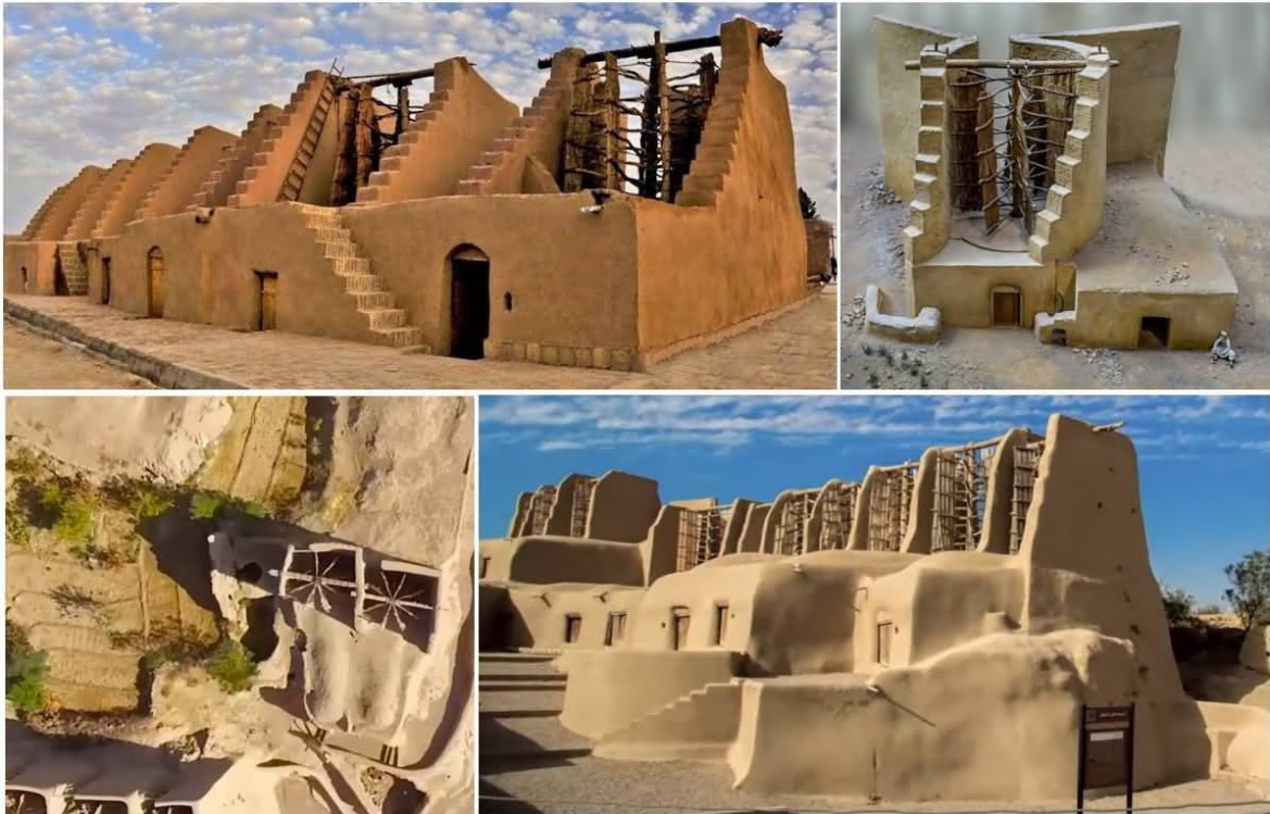
Полуторатысячелетние ветряные мельницы "барabanного типа" из Наштифана (Иран)
